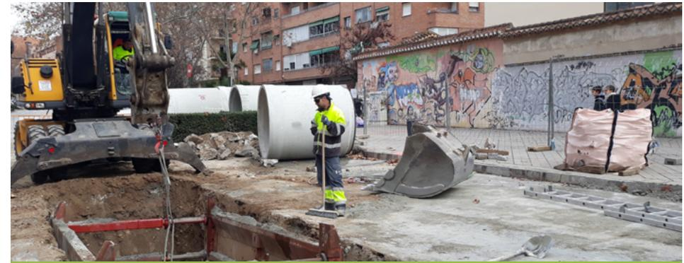
Instalación de tubería en obra del Colector Gonzalo Gallas.
